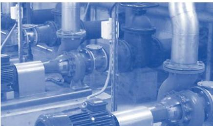
Comunicación bombeo-deposito vía GPRS/TCP-IP con redundancia por SMS. Alternancia de bombas, umbrales de arranque/paro según tarifas horarias y control de señales de fallo e inhibición de bomba.
